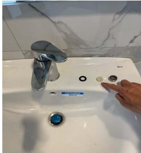
濾網零件有橡膠墊圈、濾網、外蓋
